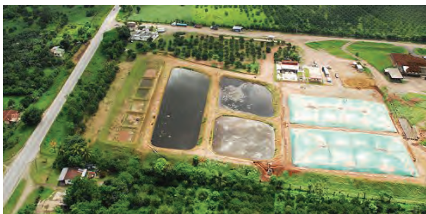
Figura 9. Sistemas de depuración biológica por oxidación
